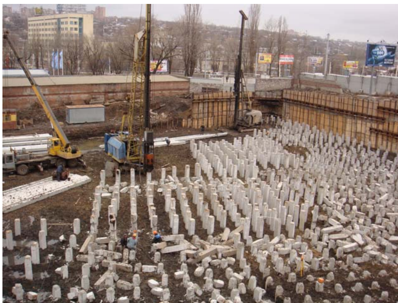
Ростов-на-Дону, пересечение ул. Красноармейская и Сиверса. 2008 г. Завершается забивка свай длиной 12 м с дна котлована глубиной до 14 м, закрепленного трубами и грунтовыми анкерами. Особенности: динамическое воздействие, корни верхнего яруса анкеров попали в просадочные грунты 1 группы. В процессе производства работ были замочены в результате протечек из коллектора, который не был переложен до начала устройства котлована.
