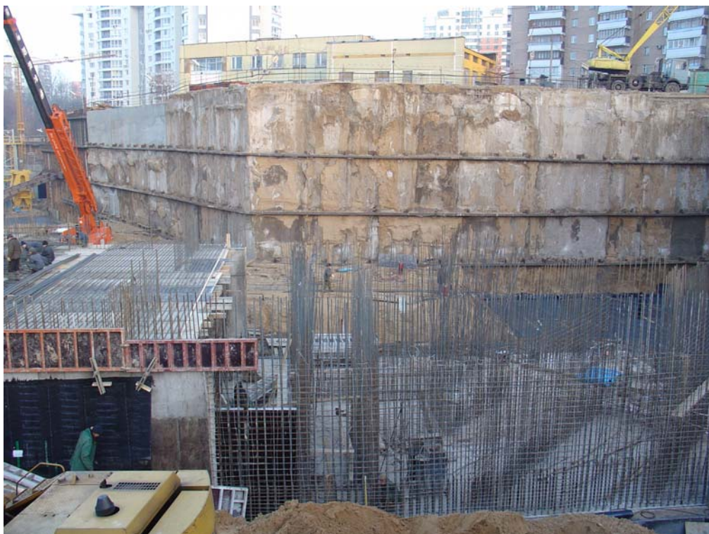
Пр-т Маршала Жукова, д.80. Котлован глубиной 19 м. Предусмотрено 3 яруса анкеров. Нагрузка в среднем и нижнем ярусах 80 т/анкер. В призме обрушения 17 этажный дом.
