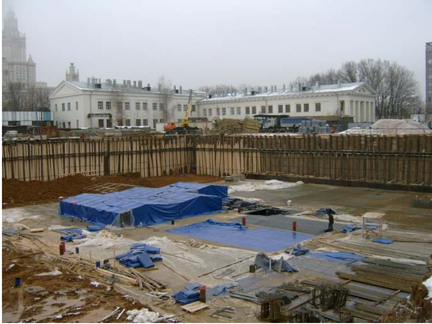
МГУ, Котлован для строительства нового корпуса, глубина 8...9 м, крепление: трубы б/у и грунтовые анкера.
