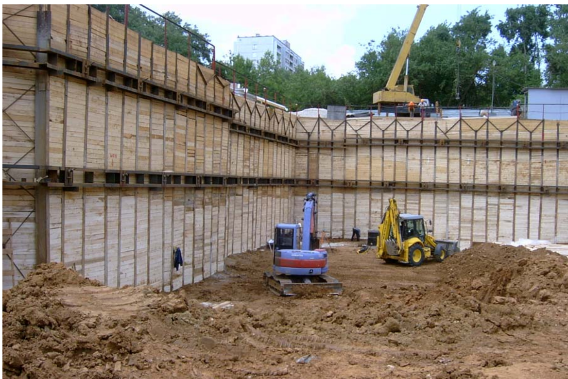
Ленинский пр-т, д. 126. котлован глубиной 11 м.
