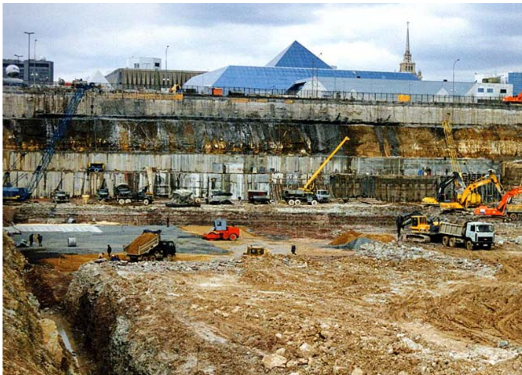
Москва-Сити, апрель 1997 года, фрагмент котлована, вид на Экспоцентр, общая глубина котлована до 30 м. Ведутся работы по установке анкеров-РИТ на верхнем горизонте.
