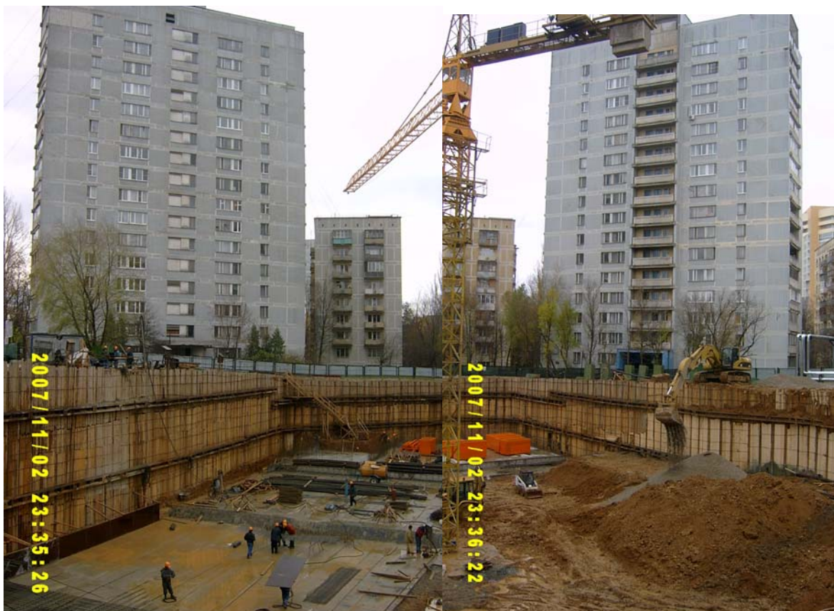
Рублевское ш. вл. 111а, борт котлована с ограждением сваями из стальных труб и анкерным крепление под 17-ти этажный дом, до дома одна глубина котлована.
