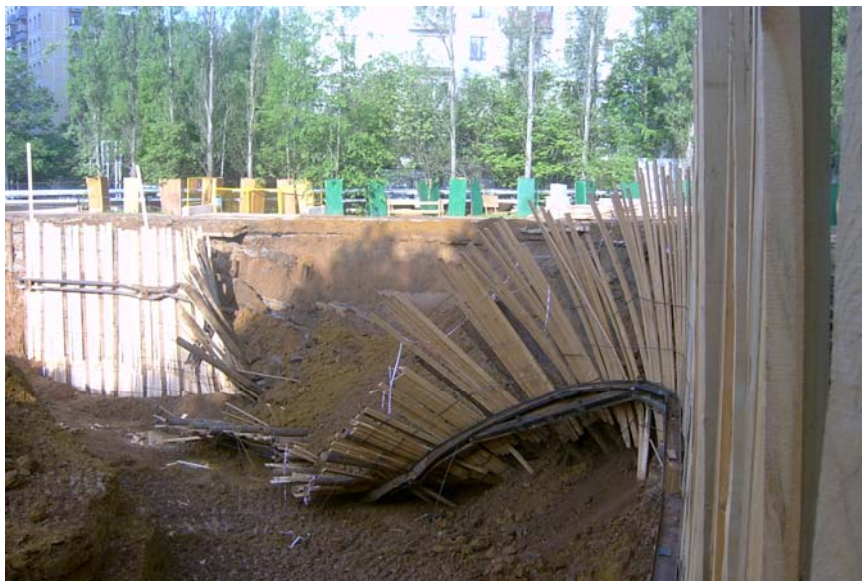
Вид обрушившегося борта котлована, мойка справа, глубина котлована с левой стороны до уровня анкеров верхнего яруса менее 2,5 м, с правой стороны со стороны мойки 4 м.
