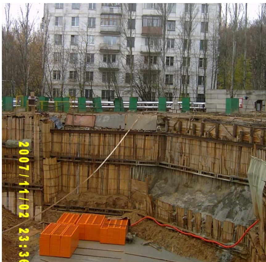
Вид борта котлована после выполнения восстановительных работ.
