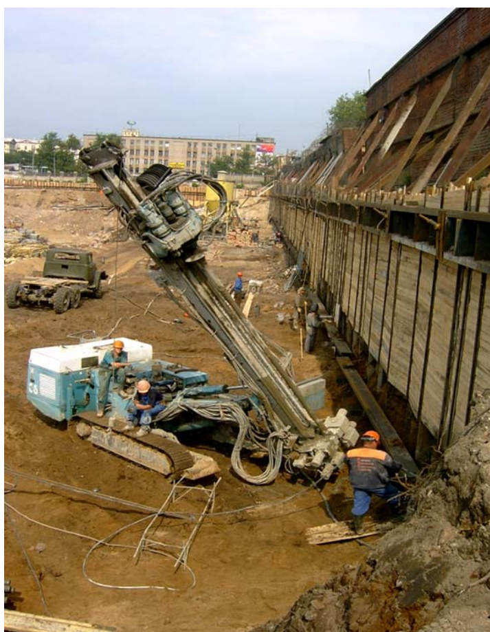
Установка анкеров второго яруса. Здание, находящееся в аварийном состоянии "прикрепили" подкосами к трубам ограждения котлована, чтобы в случае обрушения стены обломки не упали на головы работающим в котловане.
