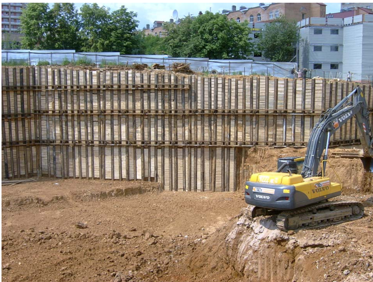
Вид борта котлована глубиной до 15 м, ул. Архитектора Власова, 2007 г. Применены трубы повторного использования диаметром 325x10 длиной до 20 м, закрепленные грунтовыми анкерами, установленными в 2-3 яруса.
