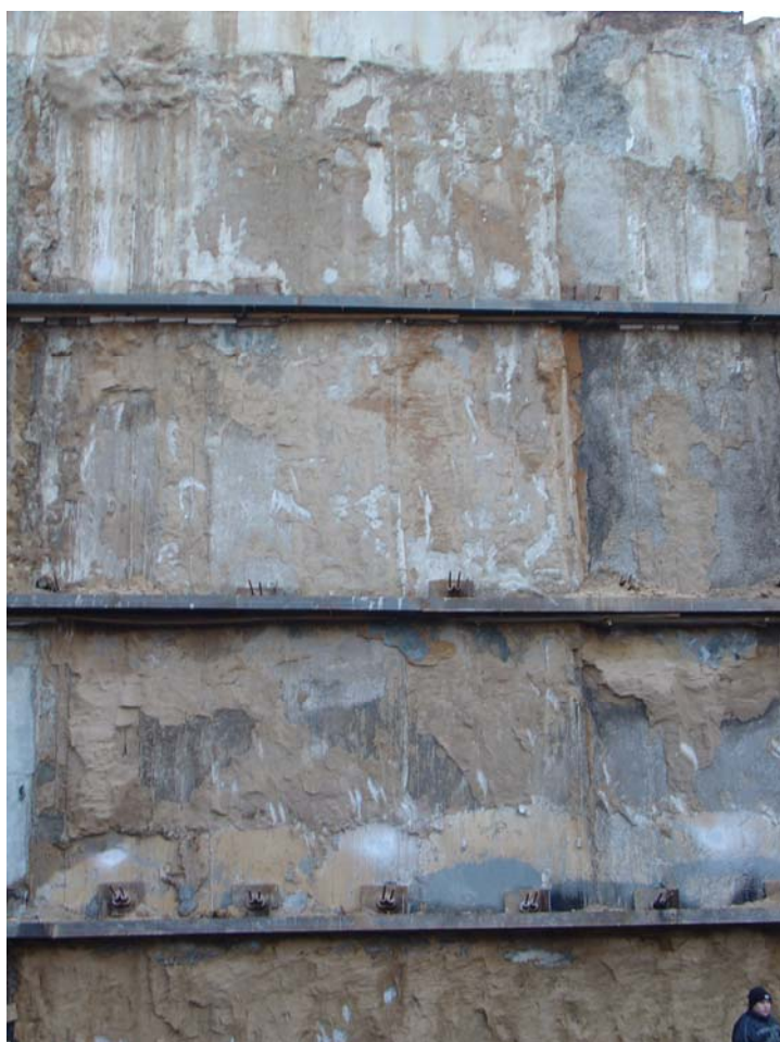
Пр-т Маршала Жукова, д.80. Котлован глубиной 19 м. Предусмотрено 3 яруса анкеров. Нагрузка в среднем и нижнем ярусах 80 т/анкер.
