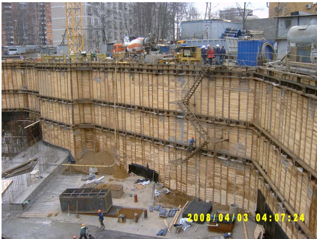
Ленинский проспект, д.106, 2008 г. Котлован глубиной 14 м, грунтовые анкера установлены в три яруса. Строительная нагрузка на бровке котлована, принятая в расчетах 2,0 \text{ т/м}^2 . Башенный кран, установлен в призме обрушения на сваях.
