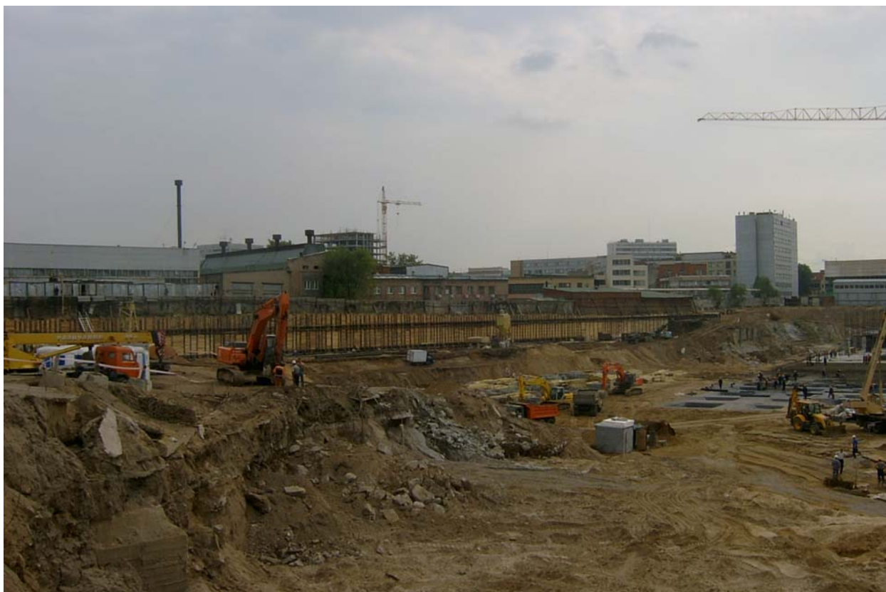
Вид фрагмента котлована (третья часть) для строящегося торгового центра "Ашан" на ул. Вавилова-3 вид со стороны третьего транспортного кольца.
