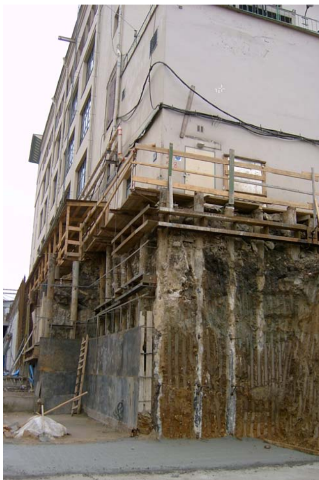
Строительная площадка, подготовленная для работ по устройству свай под высотное здание на пр-те Вернадского – 37.,
