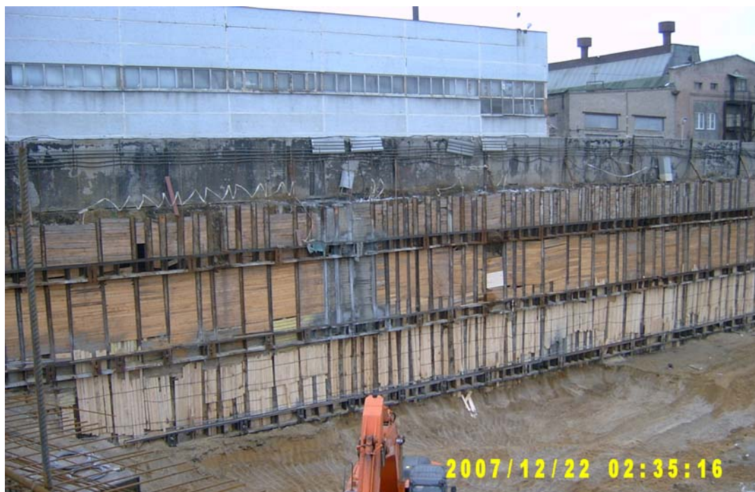
Цех инструментального завода, длина 60 м, каркасная конструкция: колонны, покрытие по балкам пролетом 18 м. Три яруса анкеров установлены под здание цеха.
