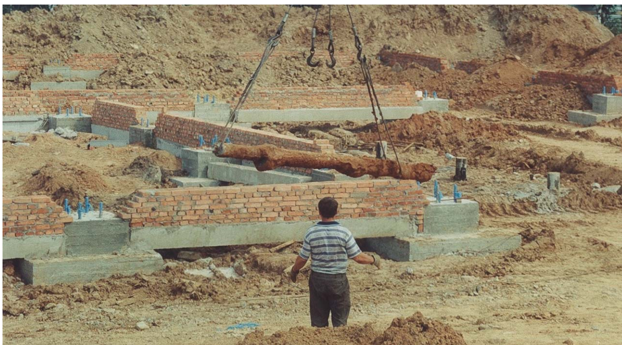
Извлечённый из грунта корень анкера-РИТ после испытания выдёргивающей нагрузкой 62,5 т, с доведением до разрушения анкерной тяги из арматуры Ат-VI диаметром 25 мм.
