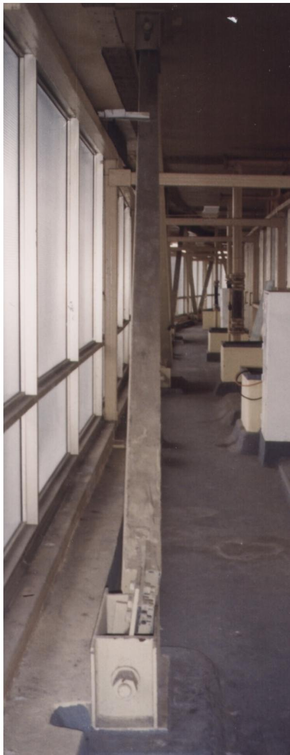
*Рис. 17 Потеря устойчивости опорного ребра вертикальной связи*
