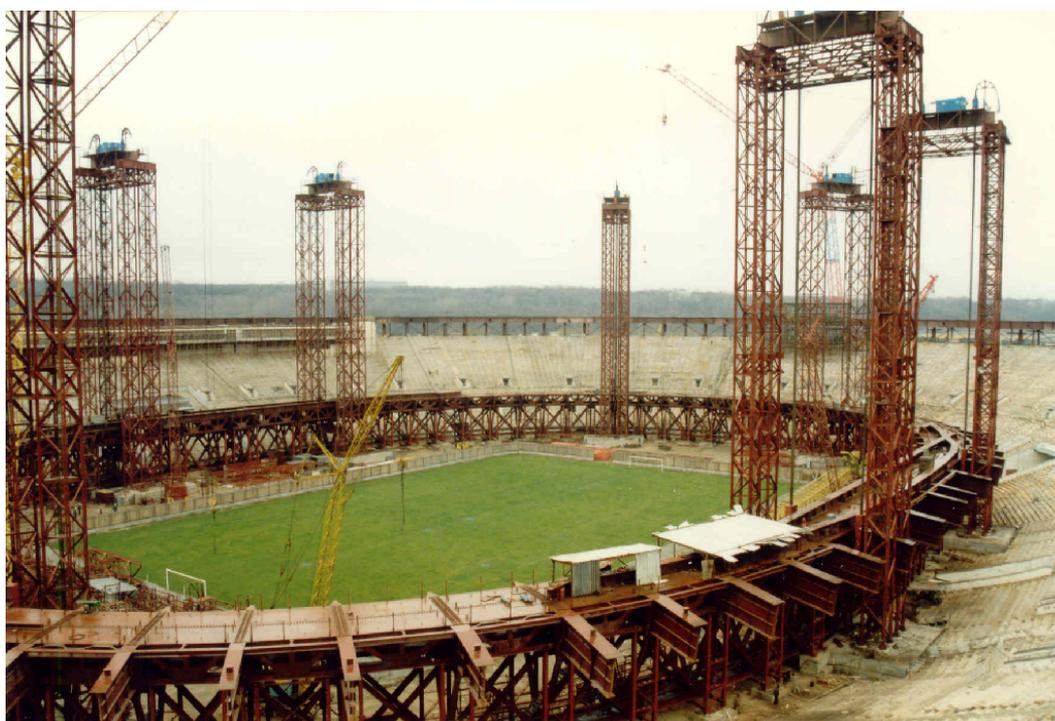
*Рис.3. Сборка внутреннего контура*
