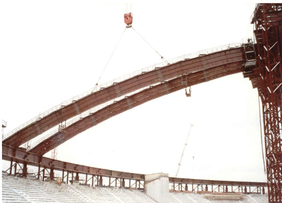
*Рис. 5. Монтаж радиальных балок*
