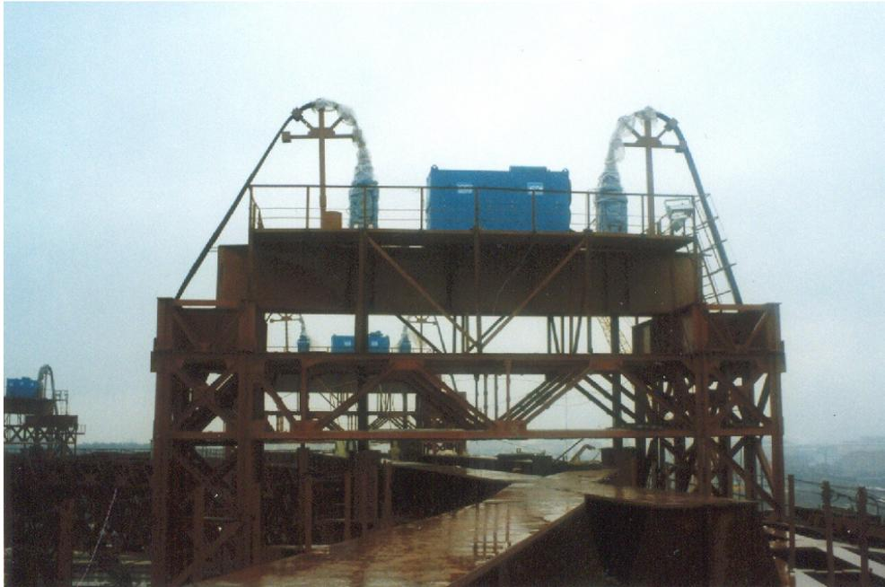
Рис. 6. Раскружаливание покрытия
