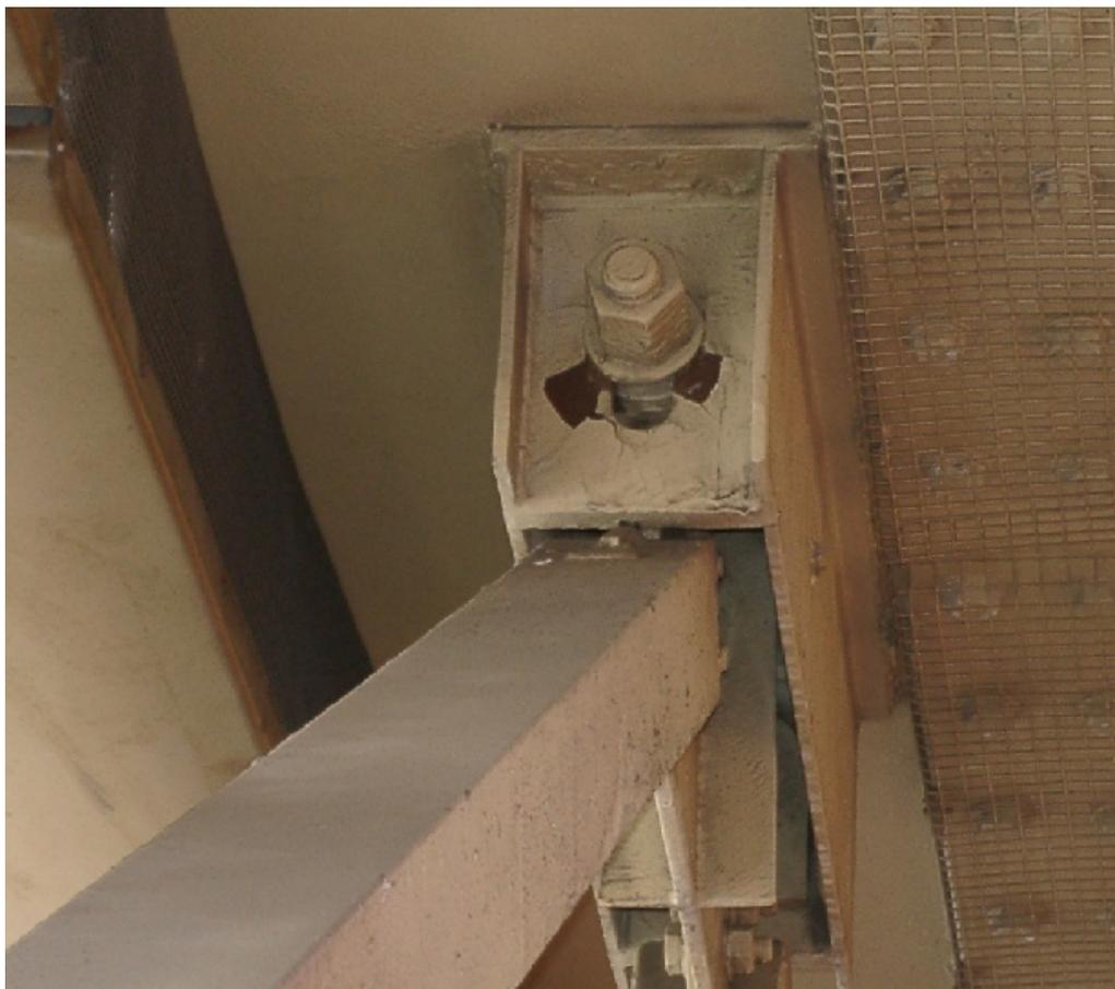
*Рис. 16. Отсутствие зазора между шпилькой и овальным отверстием*
