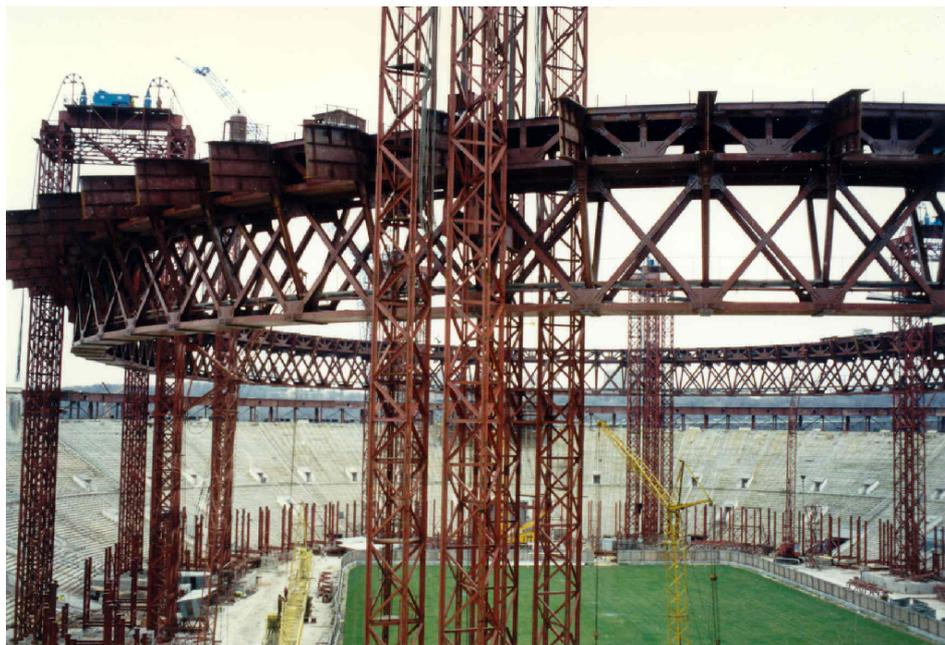
*Рис.4. Внутренний контур на проектной отметке*
