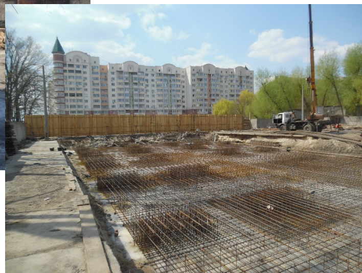
Общий вид свайного поля, подготовки и армирование ростверка
