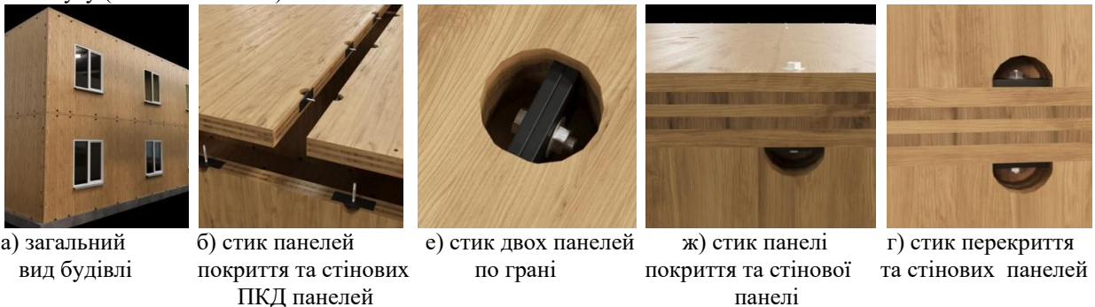
Рис. 1 Приклад застосування конектору у будівлі з ПКД або CLT панелей та варіанти з'єднання.
