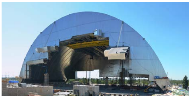
Рис. 63. Восточная стена с поднятыми откидными панелями
