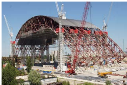
Рис. 54. 2-й подъем восточной части
