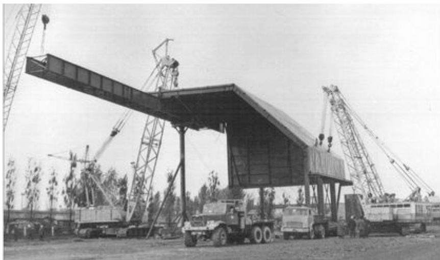
Рис. 11. Погрузка укрупненного блока клюшек
