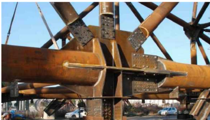
Рис. 33. Характерный узел соединения трубчатых элементов
