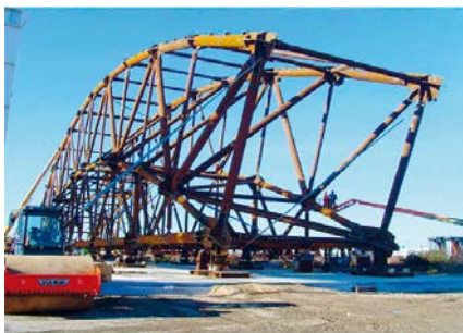
Рис. 51. Первый сегмент арки доставлен на площадку
