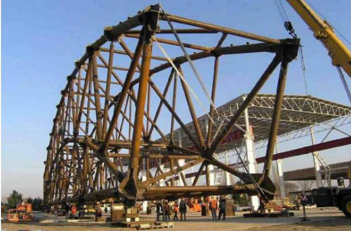
Рис. 49. Контрольная сборка пространственного блока
