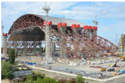
Рис. 53. 1-й подъем восточной части
