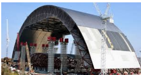
Рис. 56. Перемещение восточной части в зону ожидания
