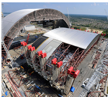
Рис. 57. Монтаж западной части Рис. 58. Объединение обеих частей арки
