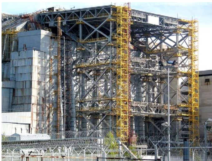
Рис. 17. Усиление контрфорсной стены
