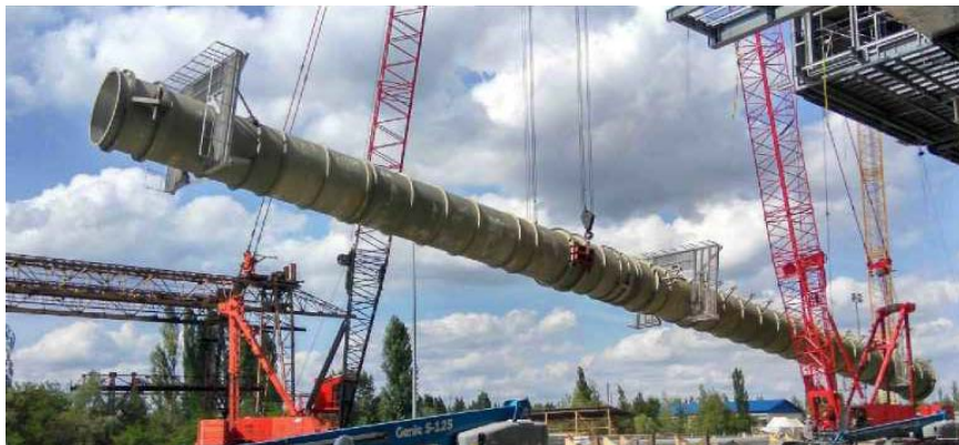
Рис. 60. Монтаж вентиляционной трубы
