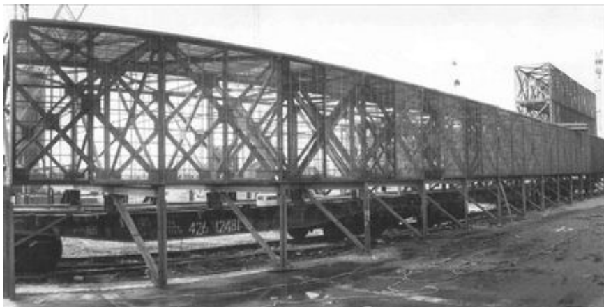
Рис. 4. "Опалубка" на колесах
