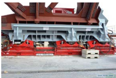
Рис. 55. Механизмы передвижения арки
