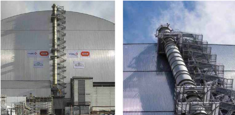
Рис. 59. Вентиляционная труба: общий вид и ее верхняя часть
