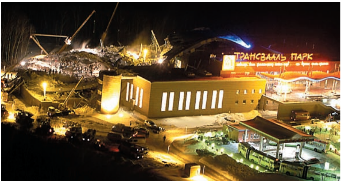
Здание СОК «Трансвааль-парк» после обрушения конструкций покрытия (фото Владара Бондарева, «Новая газета»)
