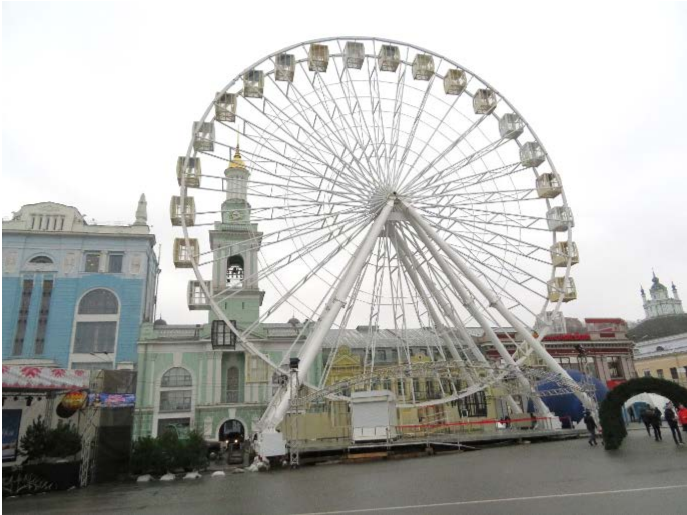
Общий вид сооружения
