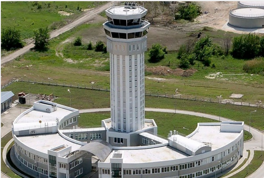
Контрольна вежа Донецького аеропорту
